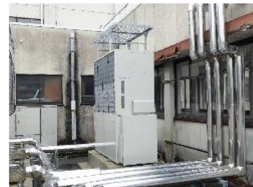
同左 電源自立型GHP施設
