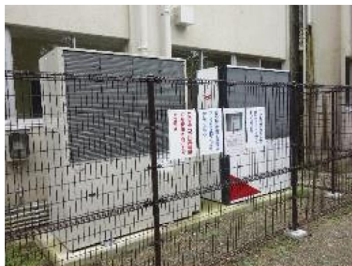
熊本市二岡中学校のGHPとLPガス貯蔵施設
