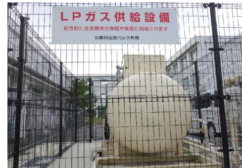
奈良県三宅町小学校への災害対応型バルクの設置
