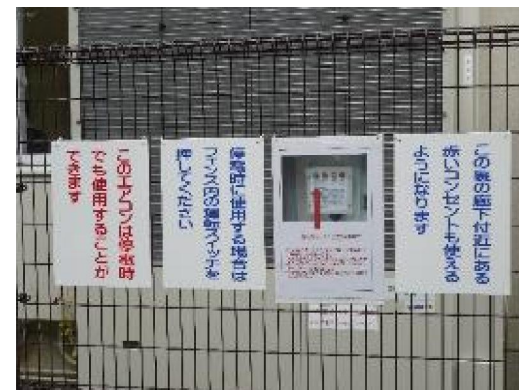
電源自立型GHPの運転マニュアルの掲示
